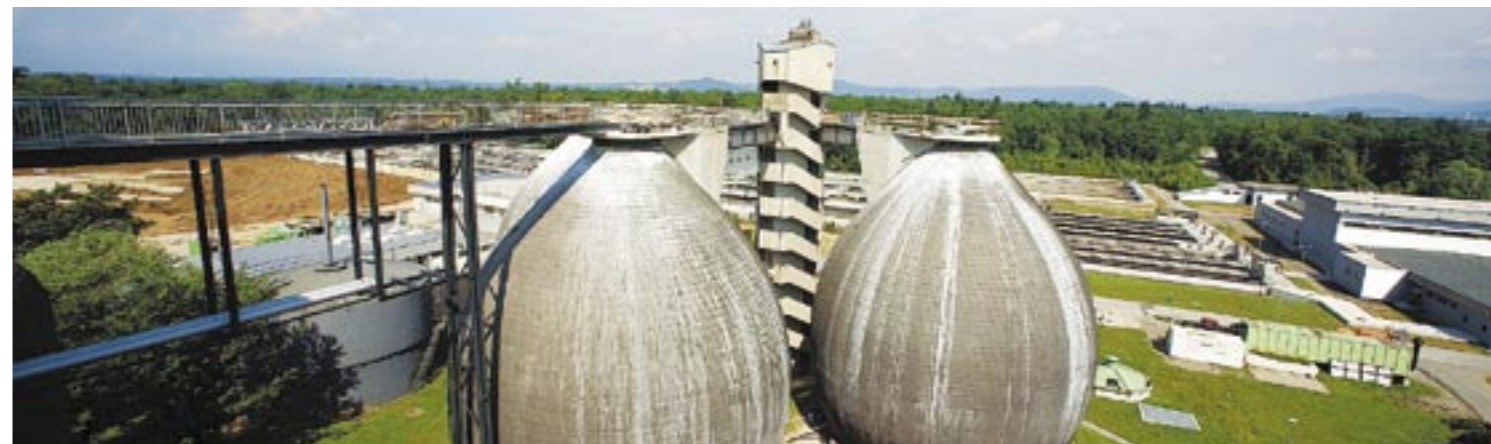
Faultürme nennt man diese imposanten runden Kolosse, in denen aus Klärschlamm Methangas gewonnen wird. Manche allerdings nennen sie Ostereier... Foto: Stadt Graz/Fischer
